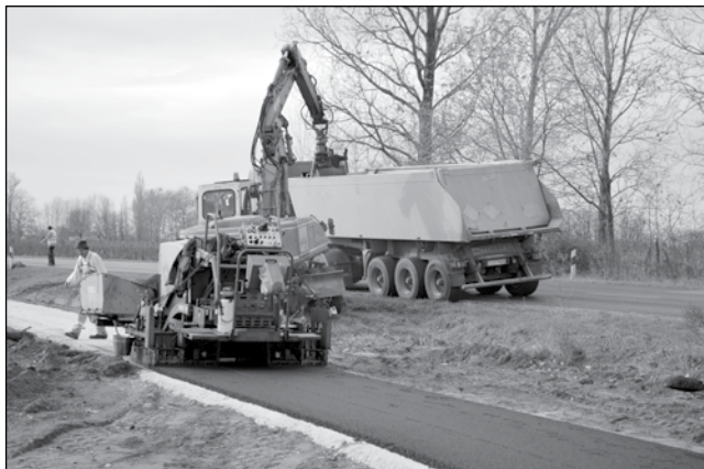
Az utolsó fázis: az aszfalterítés
